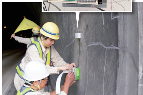
モニタリングデバイスのトンネル内での実証実験
