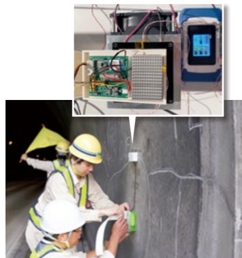
モニタリングデバイスのトンネル内での実証実験
